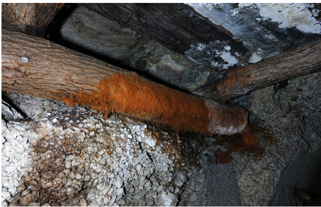
Fig. 9 – Funghi e muffe presenti sui pali di legno all'interno delle gallerie. Foto di Matilde Peterlini. / Fig. 9 – Fungi and mould on the wooden posts inside the tunnels. Photo by Matilde Peterlini.
