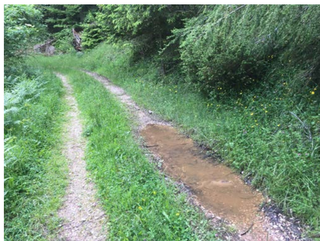
Fig. 12 – Raccolta d'acqua in depressione del terreno creata dal passaggio di automezzi. / Fig. 12 – Collection of water in depression of the ground created by the passage of vehicles.
