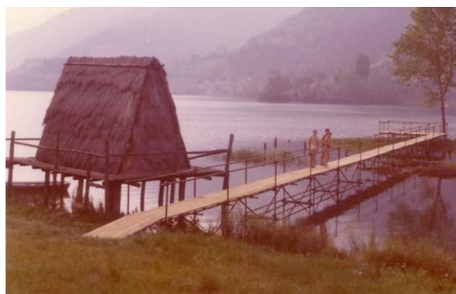
Fig. 17 - La passerella provvisoria in tubi dalmine diventa “semidefinitiva”.
