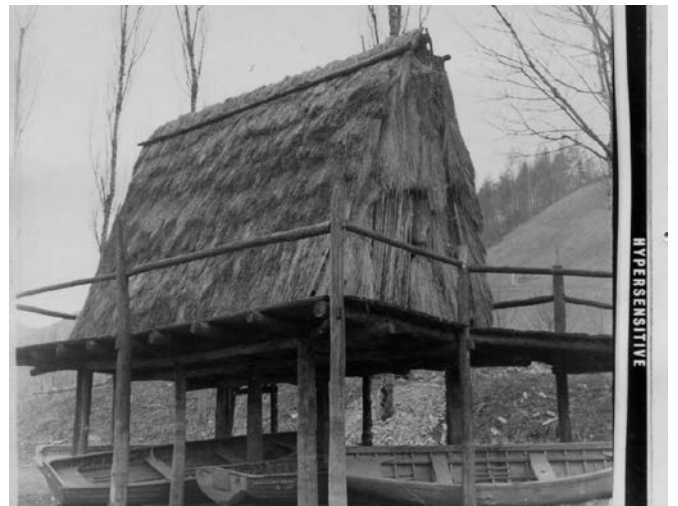
Fig. 15 - Edizioni diverse della palafitta verso il lago: il totem della valle di Ledro. L'unico momento in cui sulle sponde del lago comparvero contemporaneamente due palafitte è il 1983.
