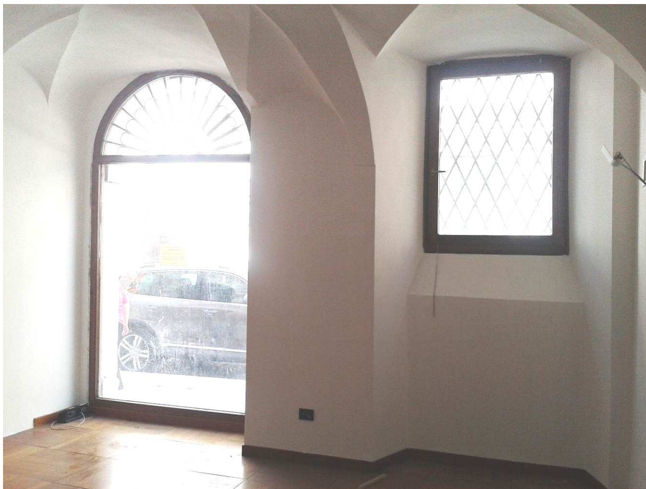
Piano Terra – serramenti verso Via Calepina
