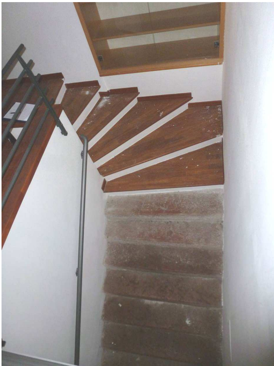
Scala verso piano interrato.
